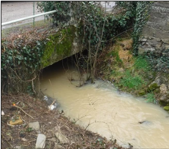
Fig. 12. Passage busé du ruisseau du Breuil, Place du Gué, source : ARTELIA
