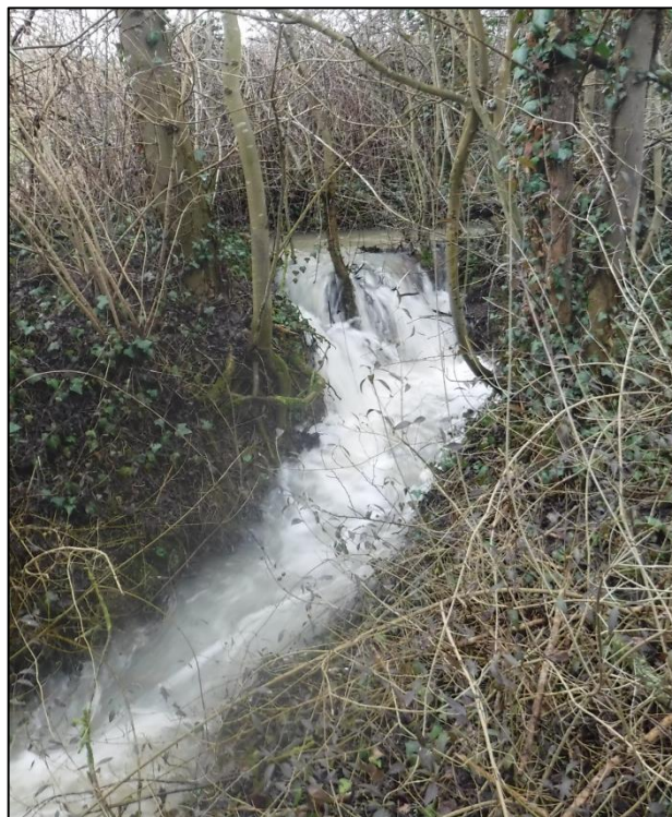
Fig. 14. Photo d'un seuil formé par une accumulation d'embâcles, ARTELIA
