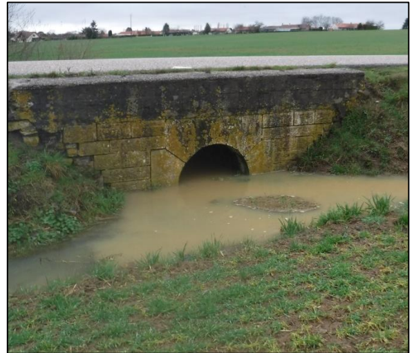
Fig. 13. Passage busé du ruisseau du Breuil, RD 67, source : ARTELIA
